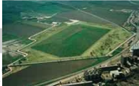
Recubrimiento de las instalaciones de producción y las escombreras de concentrados de uranio.
